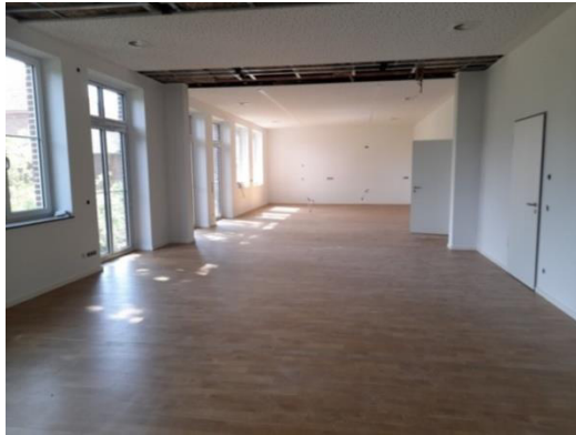
Der Fußboden ist verlegt - es folgt nun der Einbau der Schrankwände.
