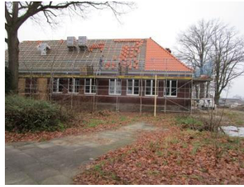
Das Dach wird komplett durch eine Firma neu eingedeckt.
