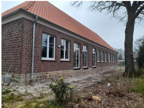
Auch an der Außenfassade hat sich einiges getan: Klinker wurden neu verfugt, die Fenster erneuert und anders aufgeteilt.
