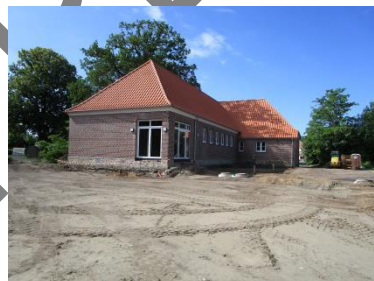
Auch an der Außenfassade hat sich einiges getan: Klinker wurden neu verfugt, die Fenster erneuert und anders aufgeteilt.
