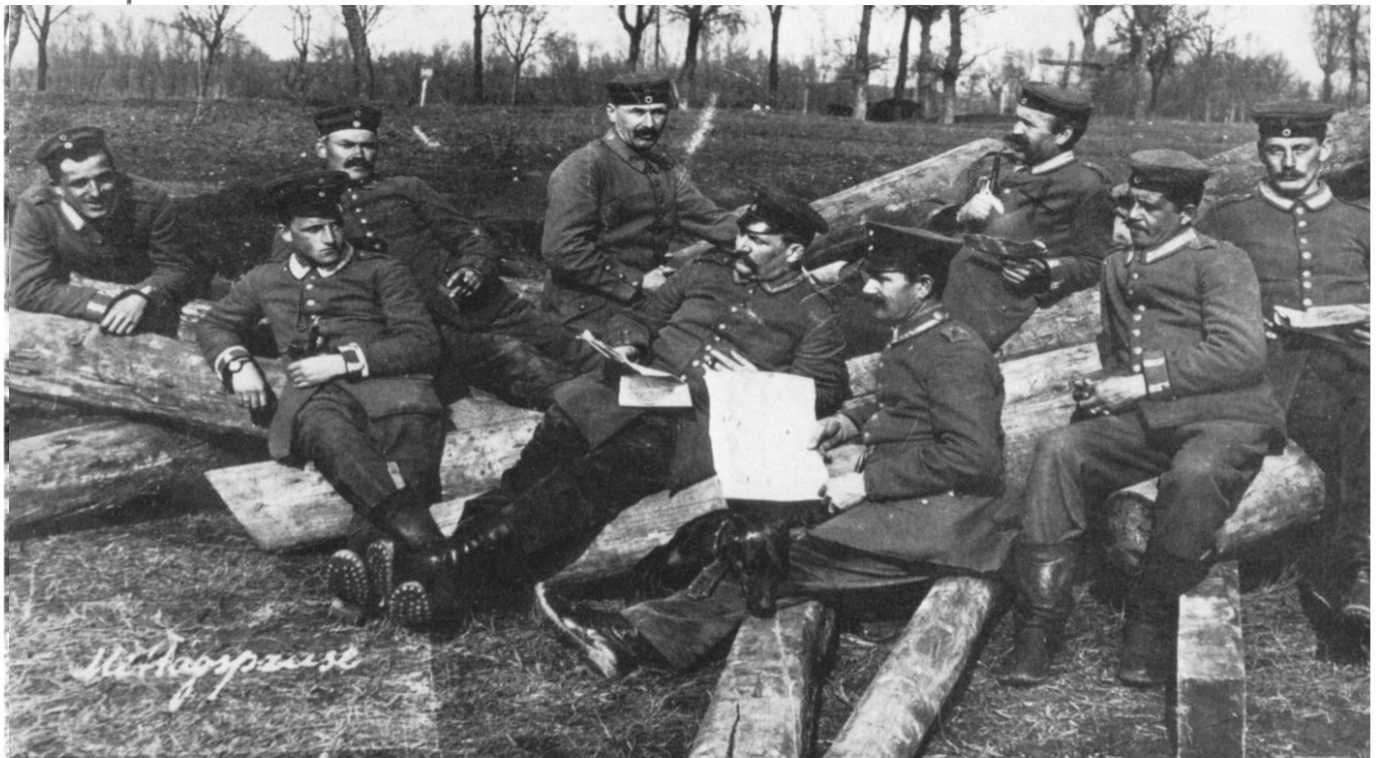
Das Militär hatte seine eigenen Eisenbahnkompanien, die beim Bau des Munitionsdepots halfen.
