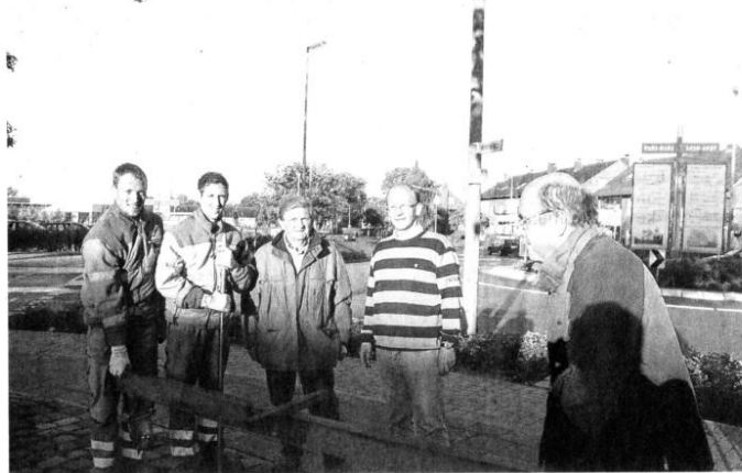
Die beiden BEG-Mitarbeiter, Manfred Rech, Michael Wiedeler und Fritz Hesse kümmern sich gestern um das Fundament der Infotafel.
