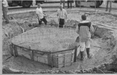
Zunächst wurde ein flächiges Fundament gegossen ...
