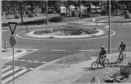
Noch sind die Arbeiten am Kreisverkehr nicht abgeschlossen.
