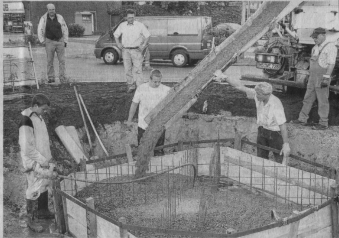
Betoniert wurde gestern das Grundfundament für die Skulptur auf dem Kreisel.
