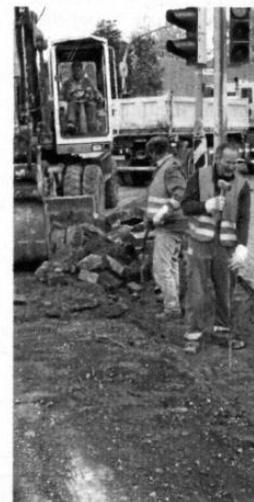
Mit Hochdruck wird am Kreisverkehr gearbeitet. Auch mit Schaufeln und Händen der Mitarbeiter. Hier lösen die „Hand“-werker gerade die schweren Bordsteinkanten (r.). GZ-Fotos (2) Böckmann
