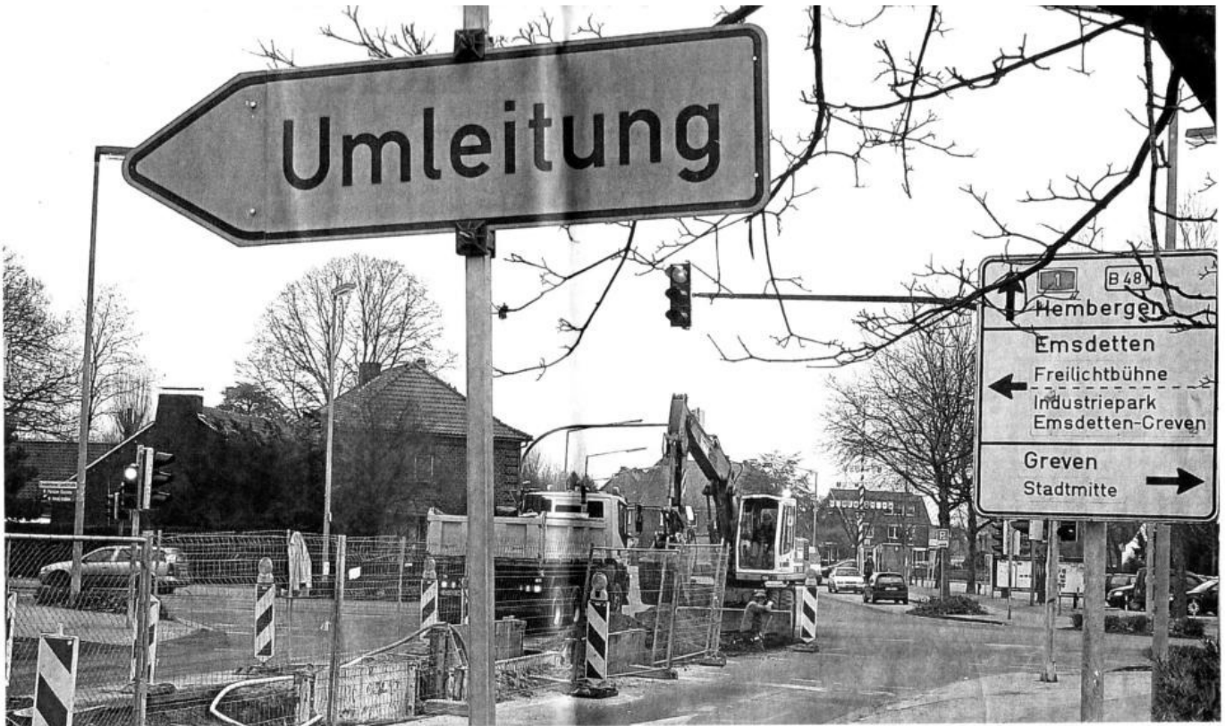
Derzeit ist Reckenfelds Ortsmitte eine einzige Baustelle. Doch bald schon wird an dieser Stelle ein Kreisverkehr vorhanden sein – mit einem interessanten Kunstwerk gekrönt. Foto: meg
