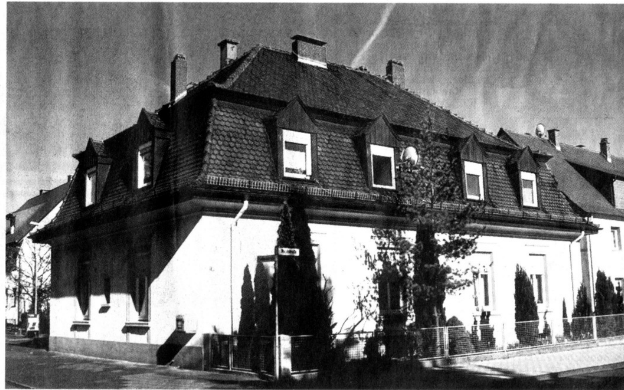
Dieses Gebäude aus dem ehemaligen Nahkampfmitteldepot Kelsterbach ist als eines der wenigen erhalten geblieben. Ein baugleiches Gebäude steht in Reckenfeld an der Industriestraße.
