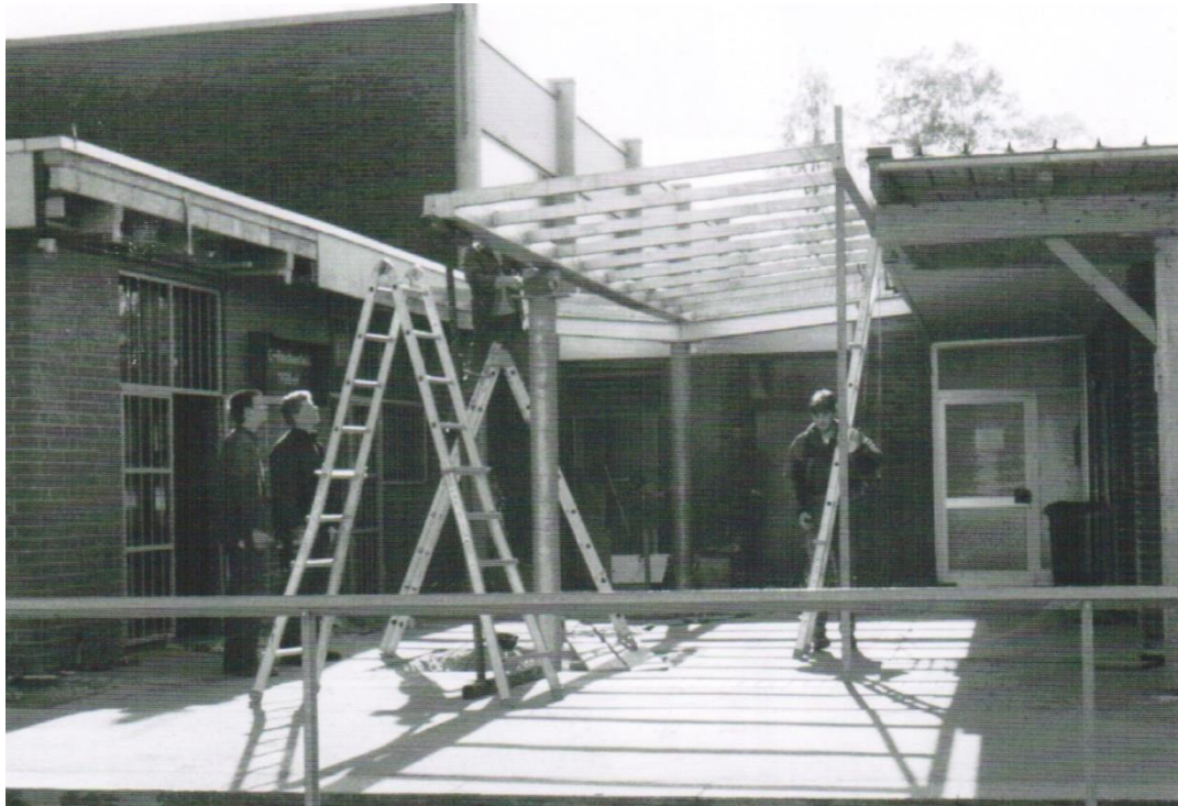
Das Vordach am SCR-Clubheim wird installiert.
