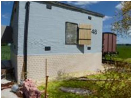
Die seitliche Ansicht vom Schuppen D 48
