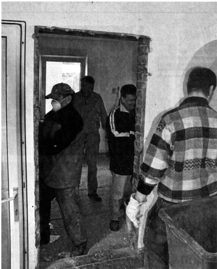
Die freiwilligen Helfer sind tagtäglich an der Arbeit, um den Umbau des Munitionsschuppens gemeinsam zu stemmen.
