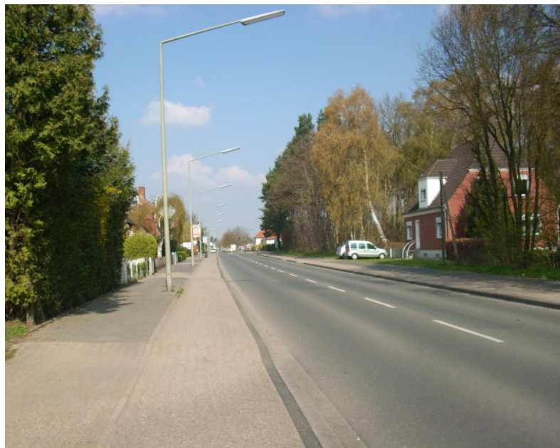
Die Grevener Landstraße im Jahr 2010 (Richtung Ortsmitte) (etwa von gleicher Stelle, wie das Foto oben)
