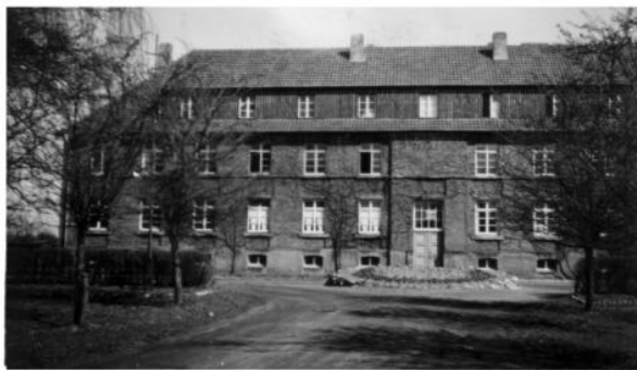
Im Reichsarbeitsdienstgebäude hatten die Polen ab 1945 ihre Küche und ein Magazin eingerichtet. Die Firma Sahle konnte ihren Betrieb dort aber fortsetzen.
