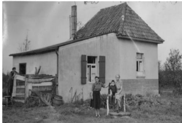
In diesem ehemaligen Trafoshäuschen wohnte eine polnische Familie mit mehreren Personen.
