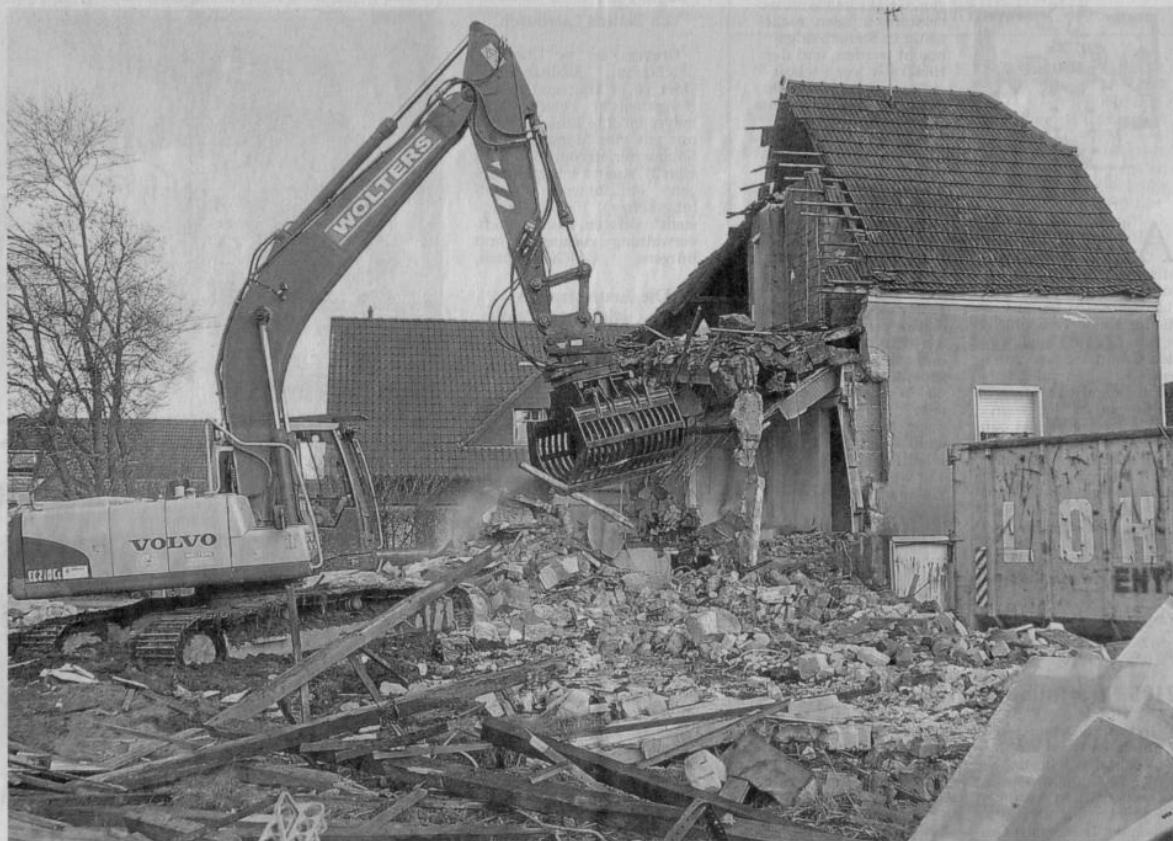
Mit schwerem Gerät wurde der ehemalige Munitionsschuppen abgerissen.
