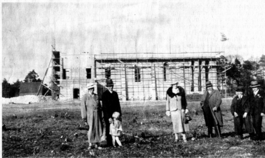
Die Franziskuskirche 1936: Ein Teil der Mauern stehen bereits.
